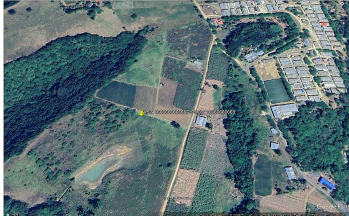
Imagen 1. Imagen satelital de referencia de la ubicación de la obra
